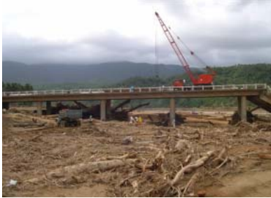
Hình 14. Lũ quét do vỡ đập mang theo nhiều cây cối và làm gãy cầu qua sông
