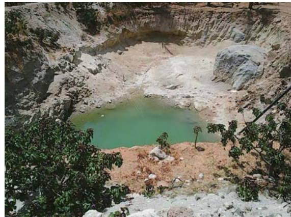
Hình 4b. Giải pháp đào ao lấy nước ngầm phục vụ sinh hoạt và tưới cây
